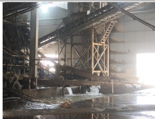
多级沉淀池及清水池
