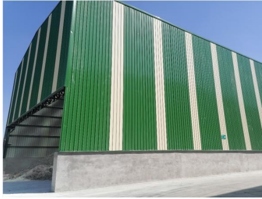
沉淀池沉渣堆场
