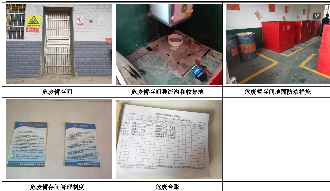
图 4-1-4 项目固废贮存情况图片
